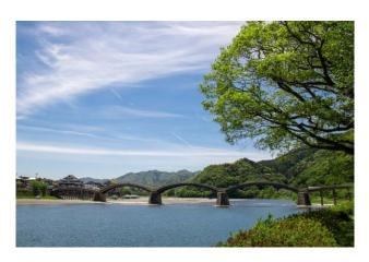
す。錦川にかかる錦帯橋は川幅約 200 メートルの河川内に 4 つの橋脚を持つ 5 連の木造橋で、中央 3 連がアーチ橋となっている世界的にも大変稀な構造となっています。全長 193.3 メートル、幅員 5.0 メートルで、継手や仕口といった組木の技術によって造られています。1673 年、建立されましたがすぐに流失、改良を加えて翌年再建された錦帯橋は、1950 年洪水で流失するまで 276 年の間、威容を保ちました。流失後、1953 年に再度、木造の錦帯橋として再建されました。現在も伝統的な日本の工法により架け直しが行われており、使用している釘も堅い洋釘ではなく柔らかい和釘を使っています。錦川は河川敷が広く、両側いずれからも美しいアーチを堪能できます。アーチの真下からも見上げることができ、下からは木造アーチ橋の複雑な構造を垣間見ることができます。
