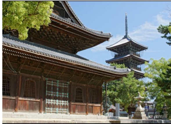
写真 2 善通寺金堂、五重塔
